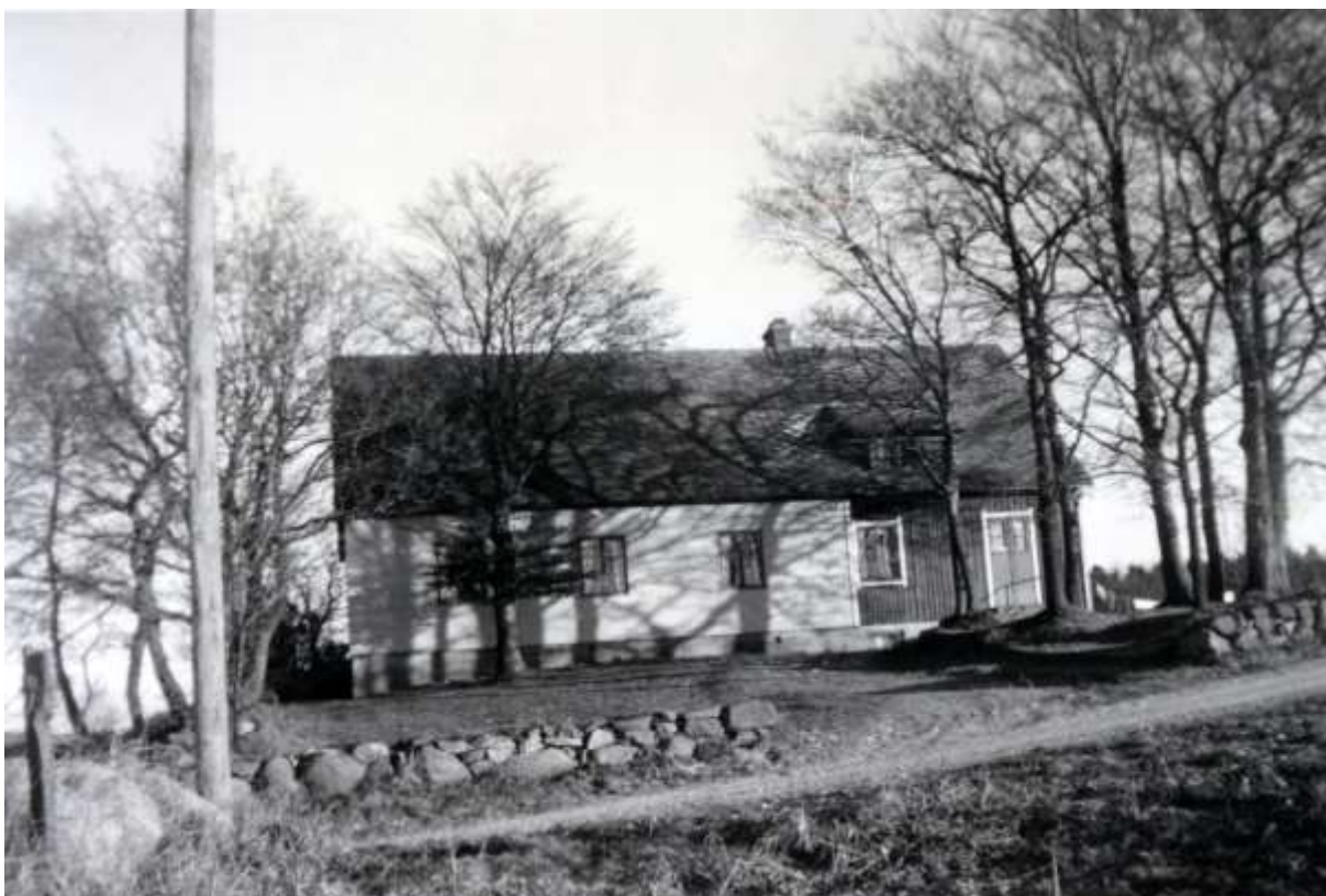
1955, spåntaket är utbytt till eternittak och väggbeklädnad med sidiplattor har påbörjats
