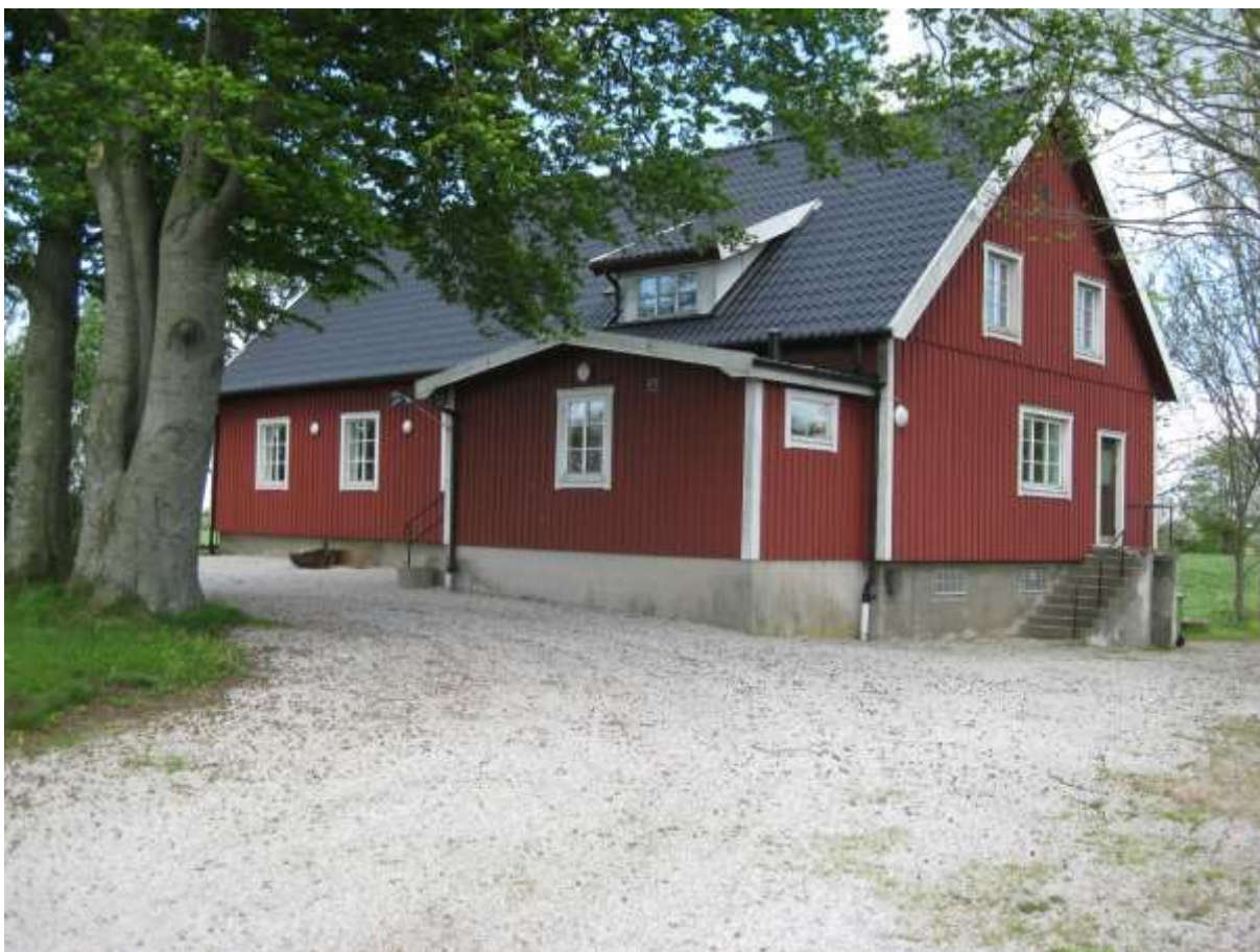
2010, Bygdegården tillbyggd och återställd med träpanel
